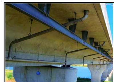
거더외부 배수관 현황
