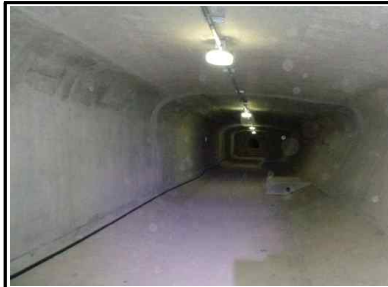
거더 내부 1런
