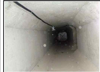
거더 내부 2런
