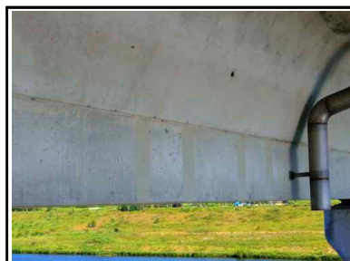
거더외부 측면 현황
